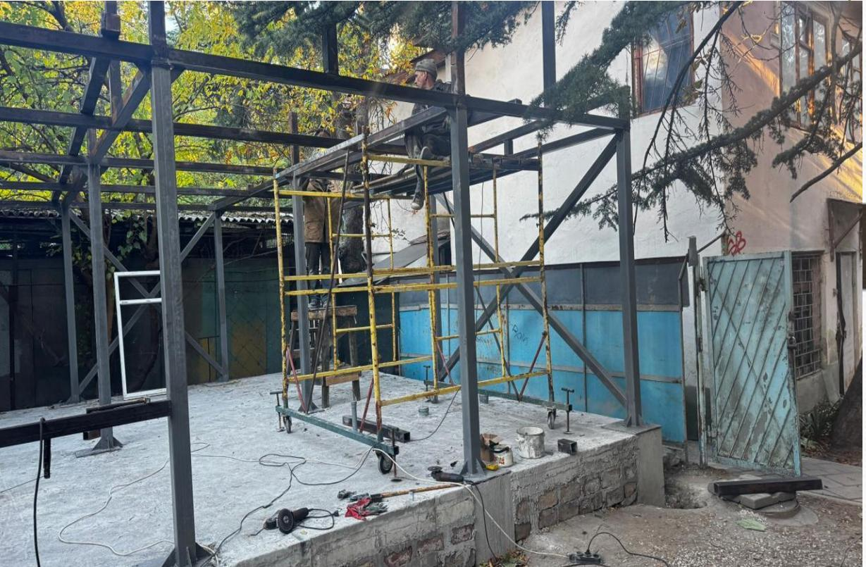
В настоящее время на объекте подведены внешние коммуникации, выполнено бетонное основание под модульное здание, монтируют конструкции здания
